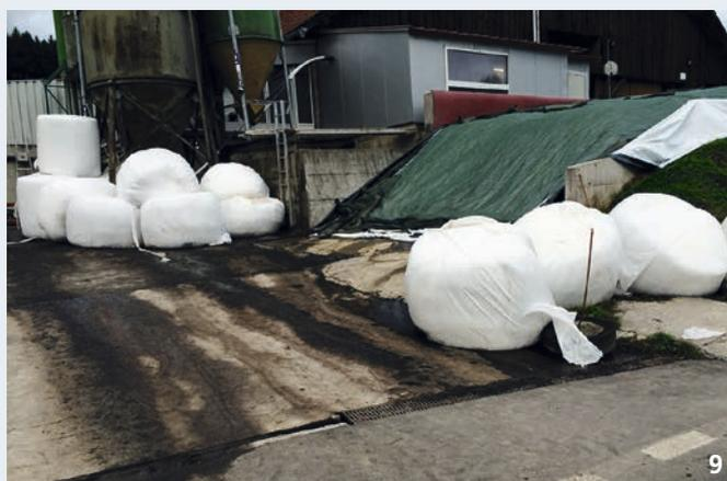
Les balles sont entreposées sur une aire pourvue d'un revêtement, l'eau qui y coule se déverse dans les eaux claires. Il y a des détériorations visibles du béton telles que des fissures, des éclats ou fers à béton apparents.
