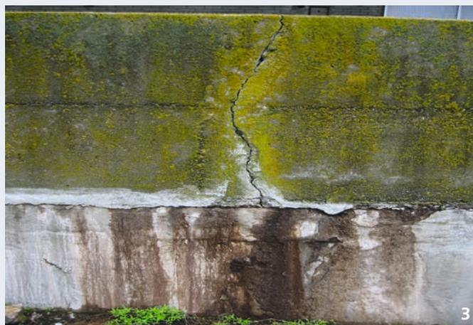
Il y a des traces de fuite de lisier sur les parois de la fosse, sous la vanne et/ou sur le sol autour.
