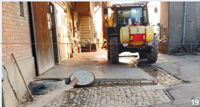
Il y a des fissures dans le béton. Les PPh et l'eau de lavage peuvent s'infiltrer ou atteindre des eaux de surface ou une grille d'évacuation.
