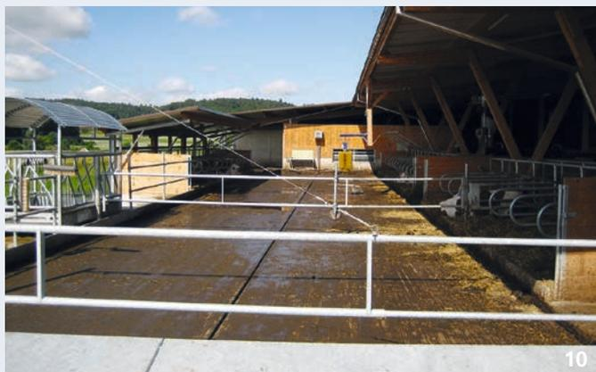
Le revêtement ne présente pas de détérioration visible, les eaux à évacuer ne s'écoulent pas vers des eaux de surface ou vers une conduite d'eau pluviale. Les eaux pluviales ne s'écoulent pas à côté de l'aire d'exercice (il y a par ex. une bordure, une pente suffisante vers l'orifice conduisant à la fosse à lisier, évacuation dans la fosse à lisier, etc.).
