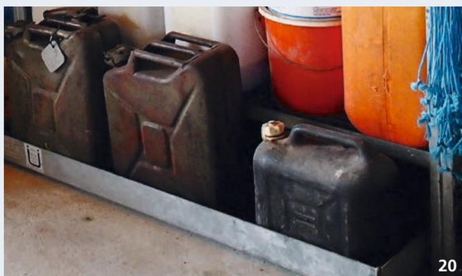
Les fluides qui fuient ne peuvent pas atteindre les eaux de surface, les grilles d'eaux claires, les grilles reliées aux égouts. Il est possible d'utiliser l'ensemble du local de stockage comme cuve de rétention. La condition préalable est que le sol soit imperméable, c'est-à-dire qu'il ne présente ni trous ni fissures, et que des mesures structurelles (par ex. un seuil de porte) empêchent les produits d'atteindre l'environnement.
