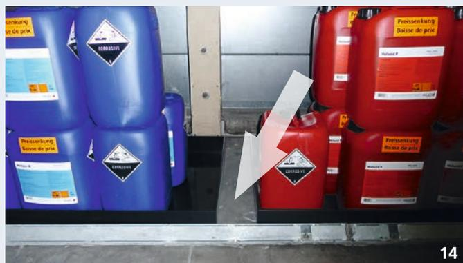
Les PPH sont stockés dans les contenants d'origine ou dans des contenants équivalents correctement étiquetés. La zone de stockage est couverte et possède un plancher sans fissures ni trous. Des mesures structurelles ou une cuve de rétention intacte évitent tout écoulement. La cuve de rétention a au moins la capacité du récipient le plus grand.
