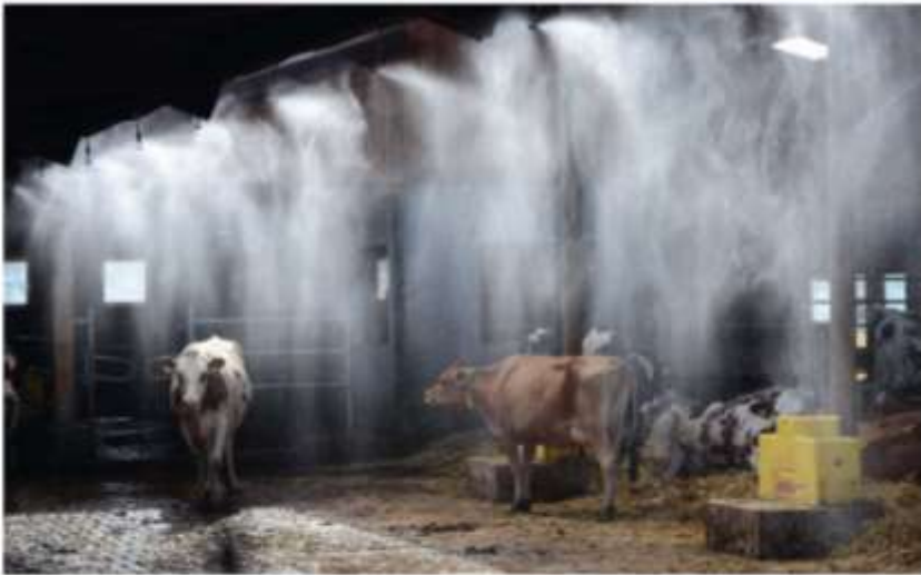
Brouillard de microgouttelettes pulvérisé pour refroidir une étable dans la région de Bâle (2018)
