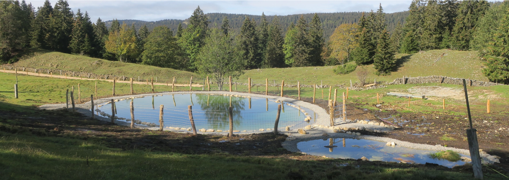
Etang de récupération d’eau de pluie avec étang de compensation - ©Montanum Sàrl
