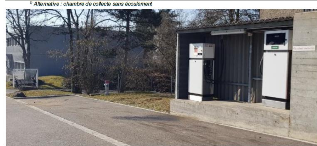
Avec une pompe stationnaire, le sol sur lequel le ravitaillement est effectué doit toujours être bétonné et étanche.
